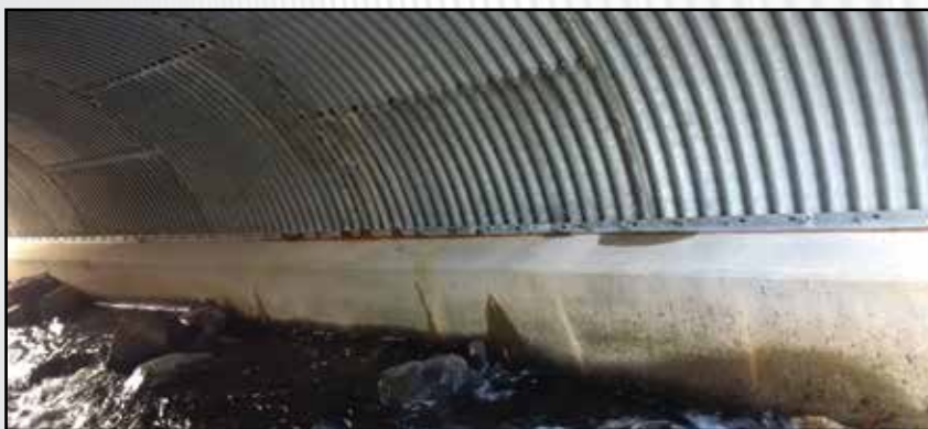
PARTIE SUPÉRIEURE DE LA SOUS-STRUCTURE EN AVAL
