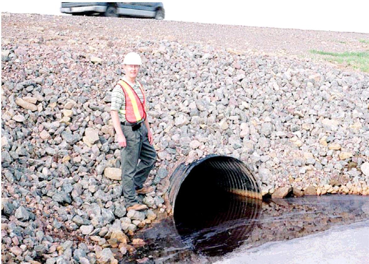
Un ingénieur d'une société membre de l'Institut pour les tuyaux de tôle ondulée inspecte l'installation d'un nouveau ponceau de TTO à strate de polymère.
