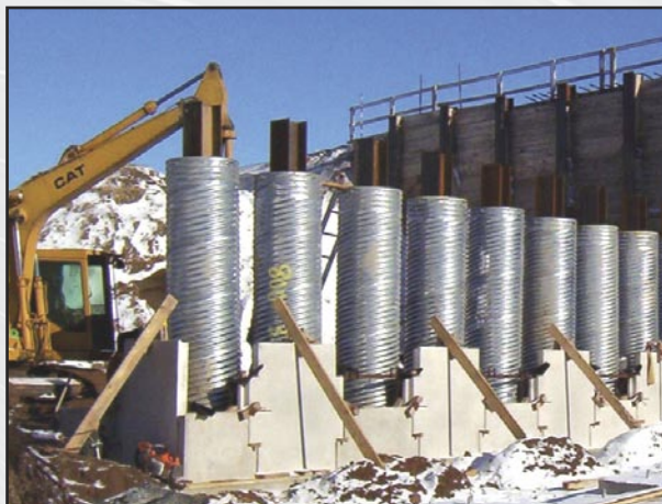
DEUXIÈME PHASE DU REMPLACEMENT DU PASSAGE SUPÉRIEUR
