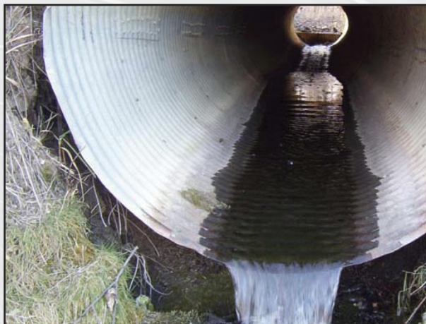
COUCHE PROTECTRICE SUR UN PONCEAU ANCIEN
