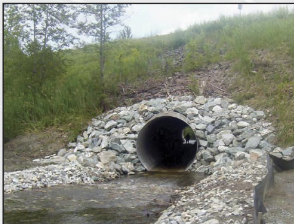
DÉFIS POSÉS PAR HUIT MÈTRES REMBLAI ET UN RUISSEAU AU DÉBIT ININTERROMPU. ENTRÉE DU PONCEAU APRÈS L'INSERTION DU TUYAU DE REVÊTEMENT INTERNE.
