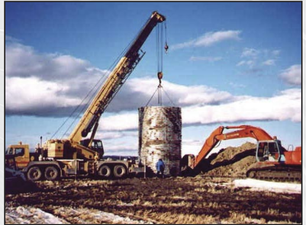
L'INSTALLATION D'UN CAISSON
