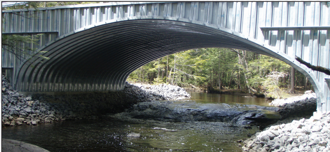
Figure 3 – Ponceau rectangulaire en tôle forte à ondulations profondes (comprend un mur d'amont en palplanches d'acier)
