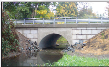
PONCEAU EN ARCHE AVEC RADIER ENTERRÉ SUR UN COURS D'EAU
